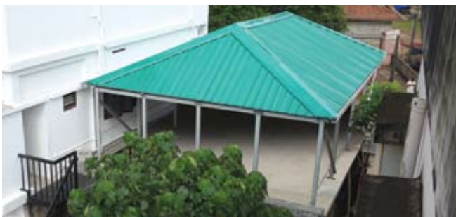
Rooftop, Aluva, Ernakulam (Kerala)
